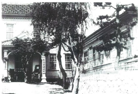
明治41年(1908)竣工 新病舎(神武山麓)
