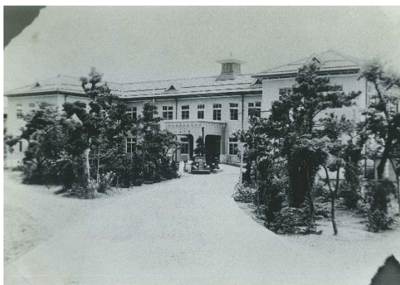
昭和7年(1932)新築移転 新病舎正面(立野町)
